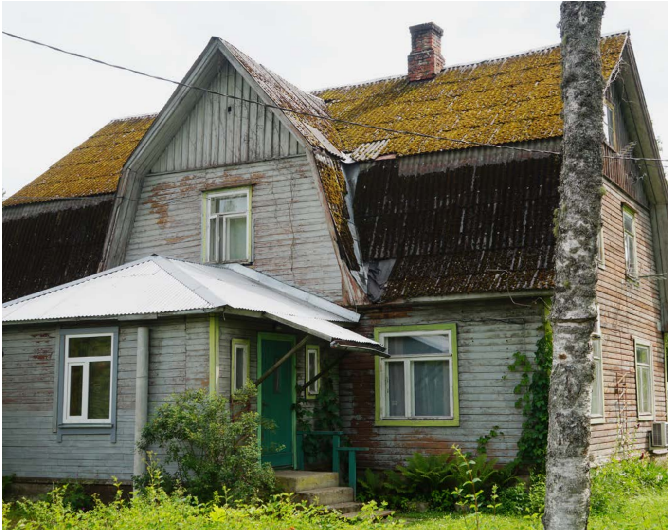
Amortiseerunud, sammaldunud ja paigatud eterniitkatus vajab tervikuna asendamist. Madalamal hoonemahul on katus juba uue eterniidiga asendatud ja harja katmiseks kasutatud plekki. Kastani 14, Aegviidu. Foto: Ü. Alev
