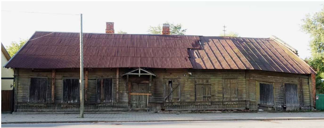
Lainepapist osaline konserveeriv katus tervikrenoveerimist ootaval mälestisel. Ülejäänud ulatuses on valtsplekist katus taganud veel veekindluse. Foto: Ü. Alev
