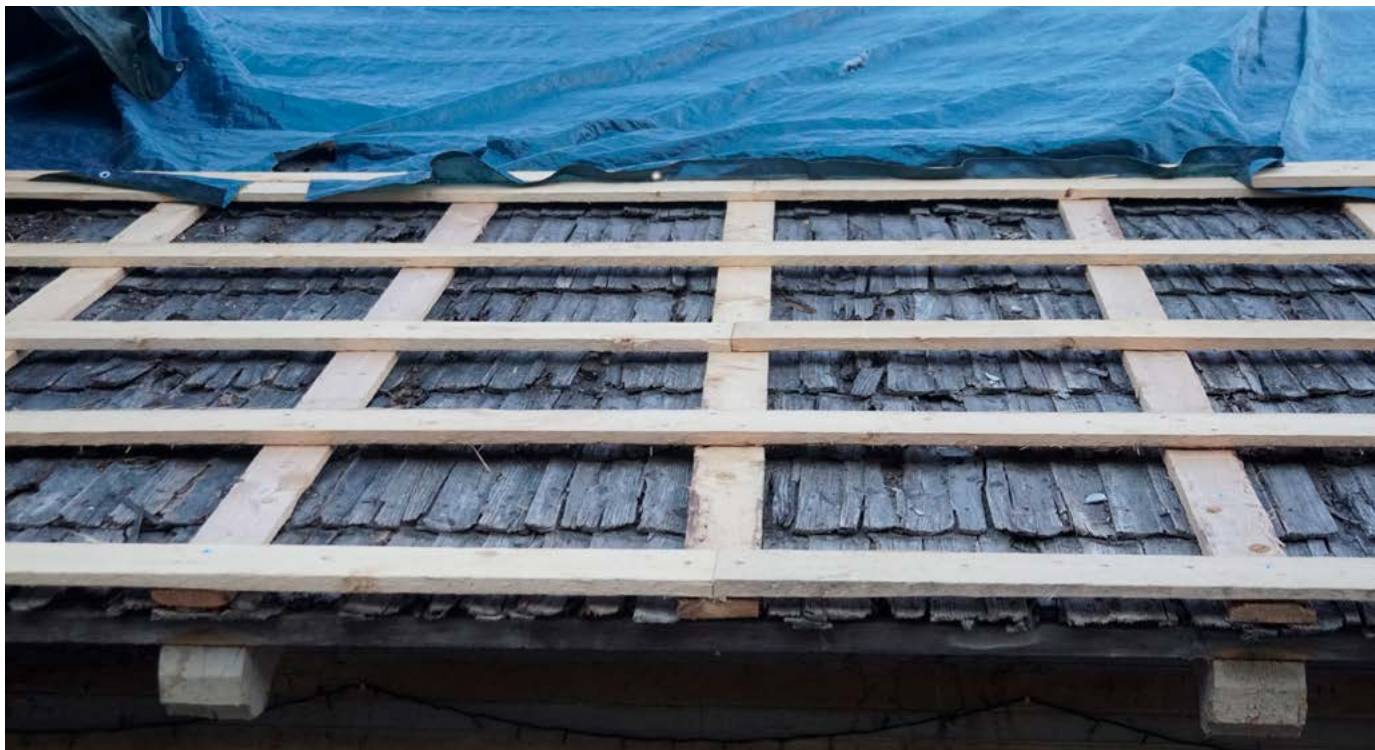
Eterniitkatuse asendamine koos roovitusega algse laastukatuse peal. Vana katusekatet ei eemaldata eterniitkatte asendamisel. Pärnu mnt 20, Pärnu-Jaagupi. Foto: Ü. Alev.
