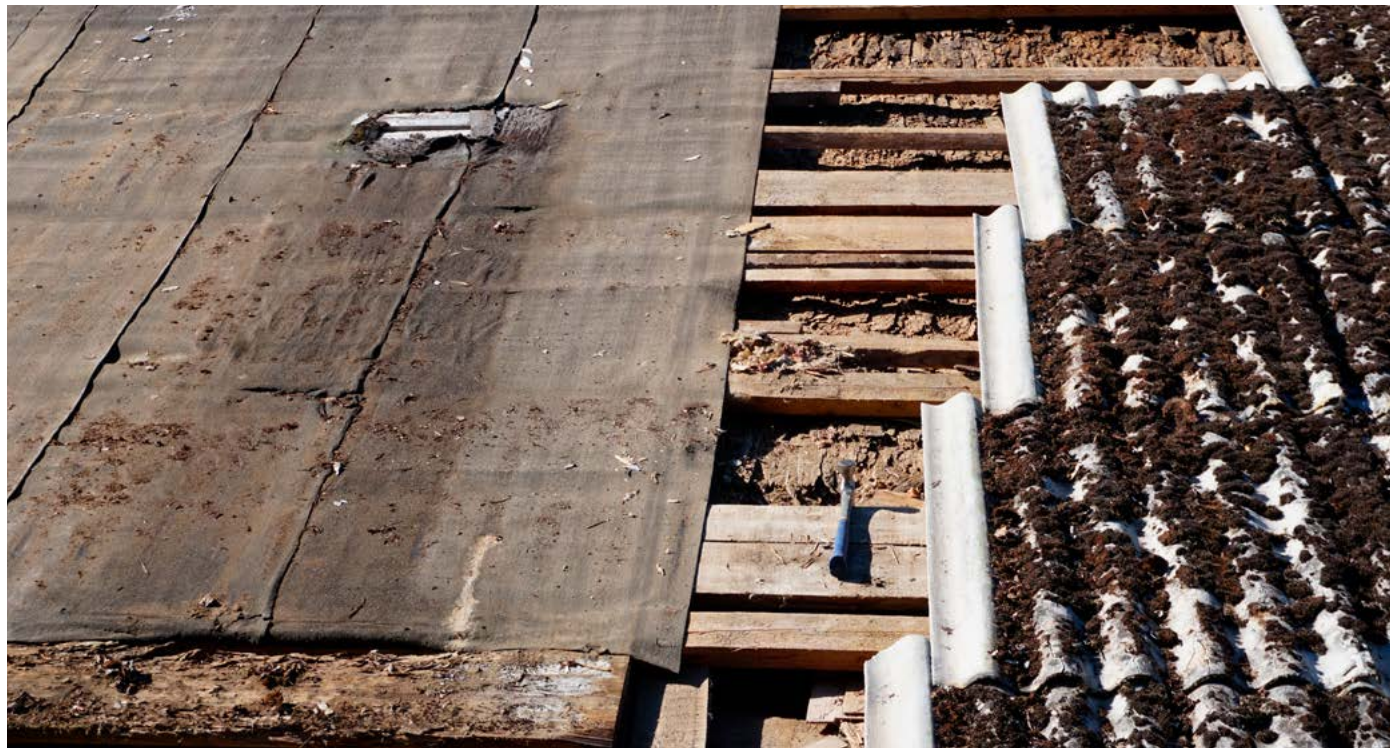
Sammaldunud ja amortiseerunud eterniitkatuse lammutamine. Näha hoone juurdeehitusel aluskattena kasutatud ruberoid (vasakul) ja aidahoone vana mahu laastukatus (paremal). Foto: Ü. Alev.
