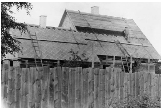
Sõjajärgse väikeelamu ehitus. Paigaldatakse eterniitkatet. Foto: Haapsalu ja Läänemaa Muuseumid SA
