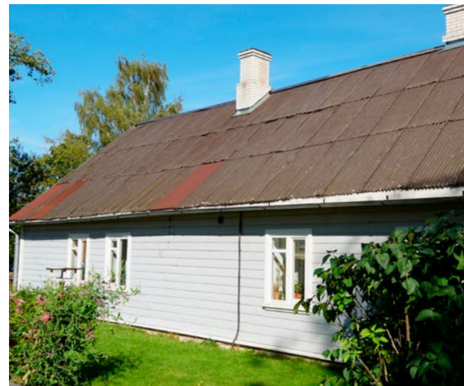
Lainepapist elamu katus ei ole pika elueaga, fotodel sammaldumine, plaatide deformeerumine ja asendatud (punakamad) plaadid. Foto: Ü. Alev
