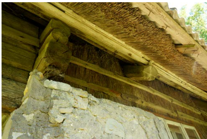
Eterniidil oli nõukogude perioodil oluline roll Eesti maa-arhitektuuri säilitajana. Eterniit on paigaldatud algse roogkatuse peale, vahel uus roovitus. Saare mõisa moonakatemaja (mälestis reg nr 20890). Foto: Ü. Alev
