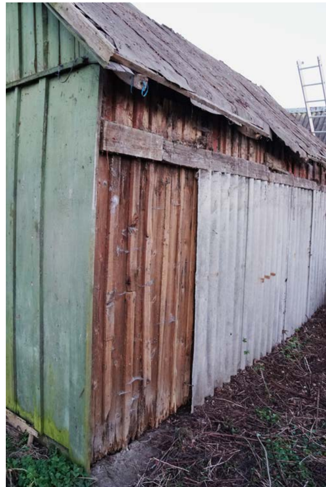
Suuri eterniiditahvleid oli kasutatud päiksepoolse mädanik-kahjustustega laudvoodriga fassaadi katmiseks väikesel eluhoonel. Foto: Ü. Alev.
