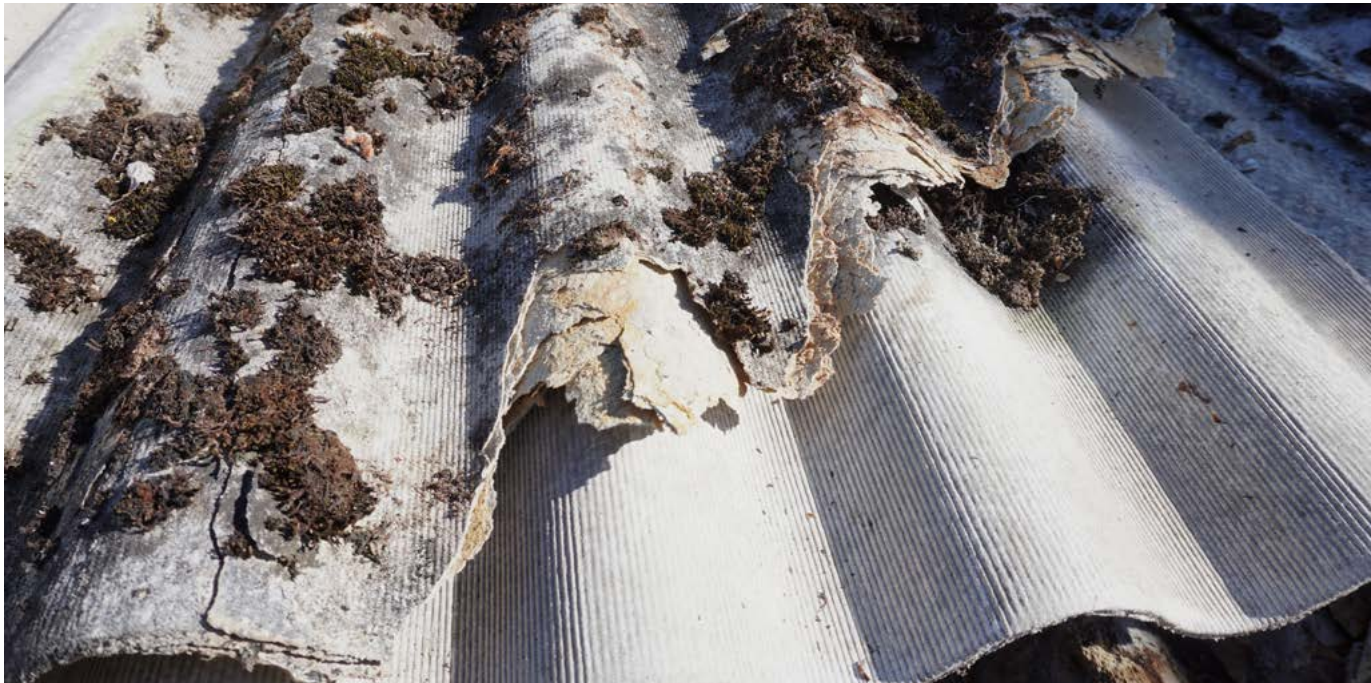
Eterniidi amortiseerumise tunnusmärgid: sammaldumine, pikipraad, murenemine ja kihistumine. Fotol olev alumine eterniiditahvel on heas korras. Foto: Ü. Alev
