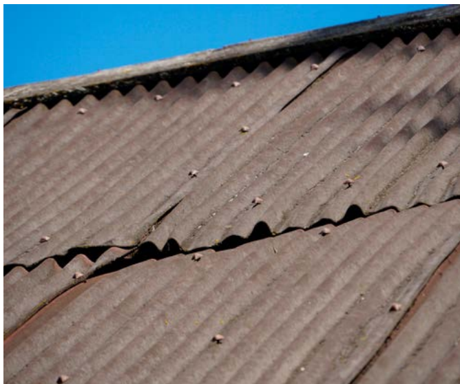
Lainepapist elamu katus ei ole pika elueaga, fotodel sammaldumine, plaatide deformeerumine ja asendatud (punakamad) plaadid. Foto: Ü. Alev
