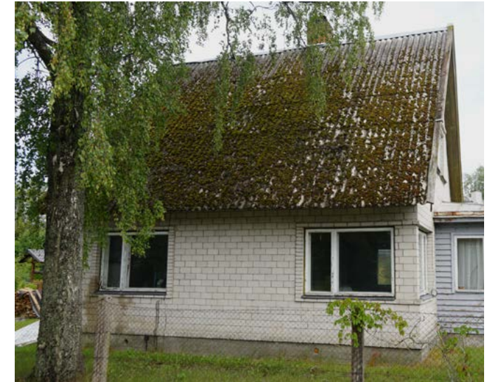
Sammaldunud eramu eterniitkatus suure kase all. Selline katus võib peale põhjalikku puhastamist välja näha uuele sarnanev ja kesta veel aastakümneid. Tamme 19, Aegviidu. Foto: Ü. Alev
