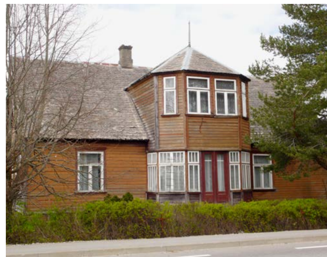
Kahekordse katmisskeemiga äralõigatud nurkadega (heksagonaalsed) siledad eterniitplaadid meenutasid kiltkivikatust. Elamu Kergu külas. Foto: M. Mändel
