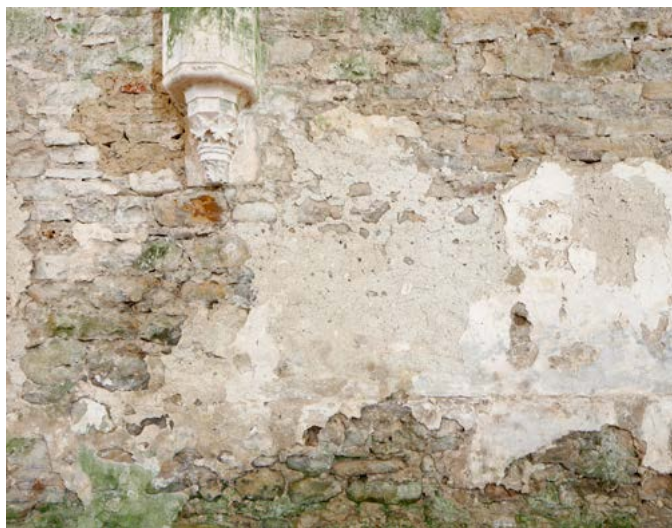
Rohevetikas Padise kloostri seinal. Vetikate elutegevuseks on vajalik vee olemasolu või väga kõrge õhuniiskus. Foto: P. Säre
