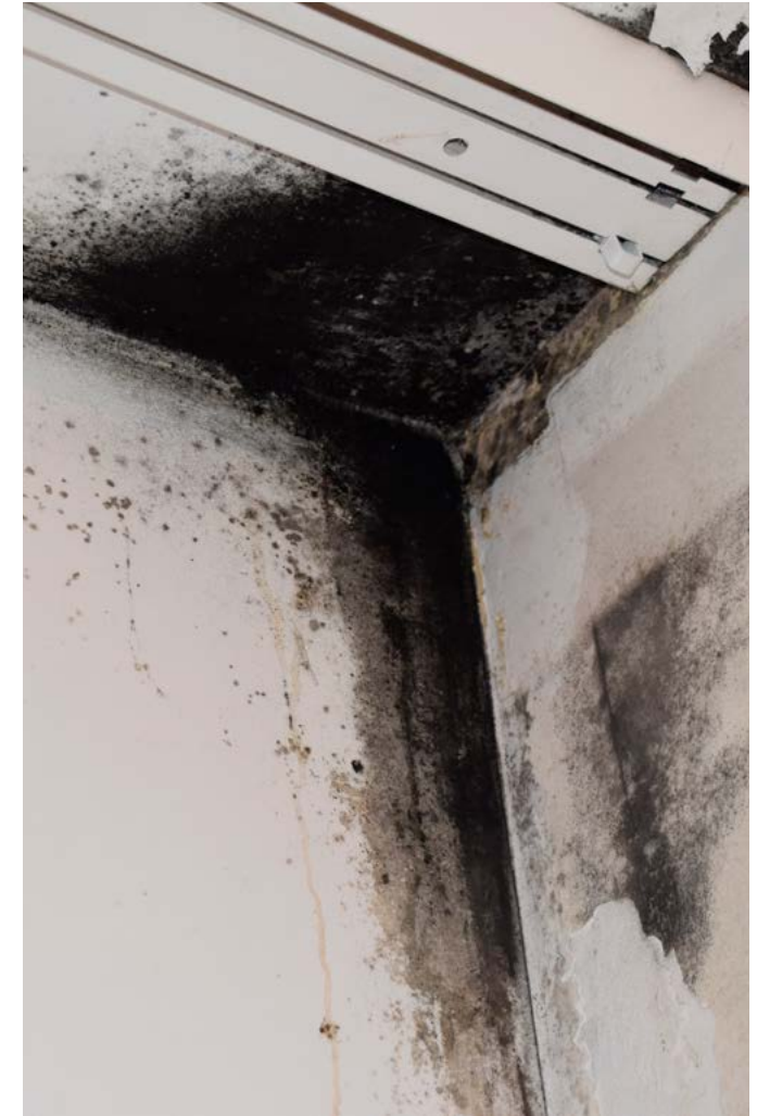
Veekahjustuse tagajärjel tekkinud must hallitus võib olla tervisele ohtlik.
