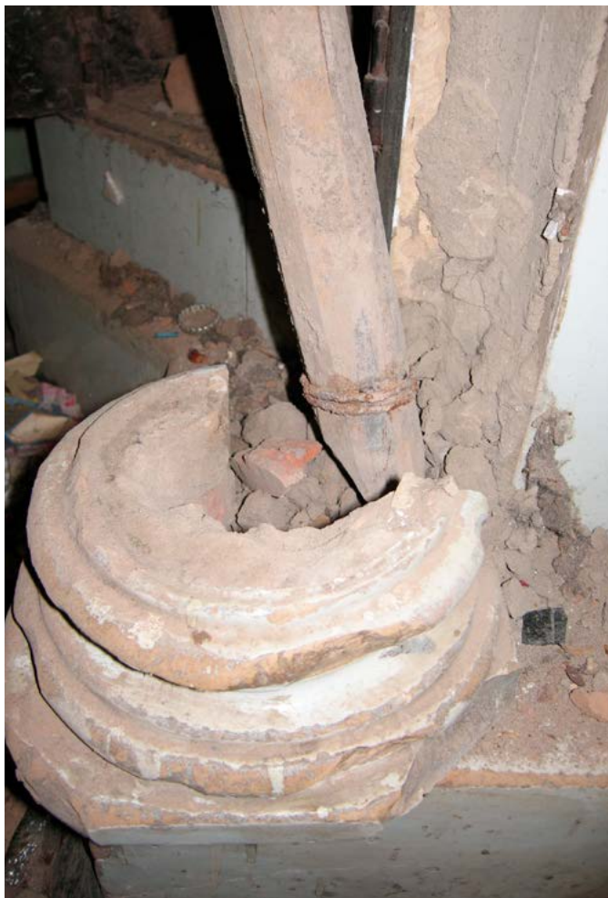
Lammutamisel ahju seest paljandunud puitvai, mille leidmine tänaseni säilinud ahjudes on haruldane. Foto: A. Ümar.
