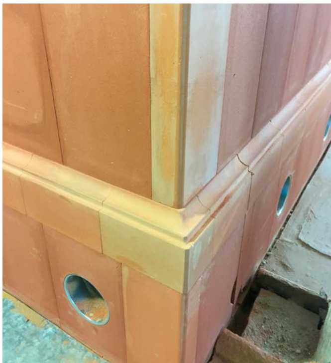
Lihtpottidest ehk glasuurimata kahlitest ahju renoveerimine. Foto: A. Ümar.
