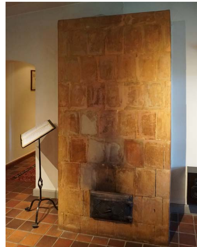
Tahmunud pinda kahhelahju ahjusuu kohal tasub proovida puhastada tuha abil. Foto: Ü. Alev.
