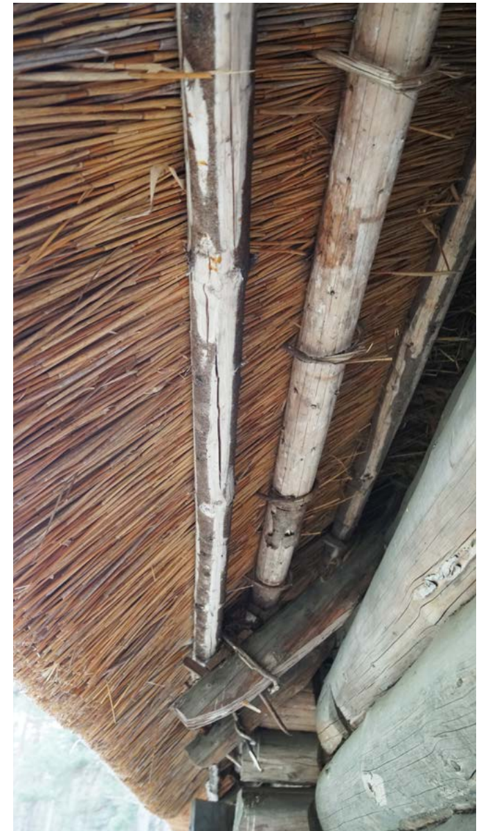
Sassi-Jaani talu roogkatuse räästaalune, EVM. Foto: Ü. Alev
