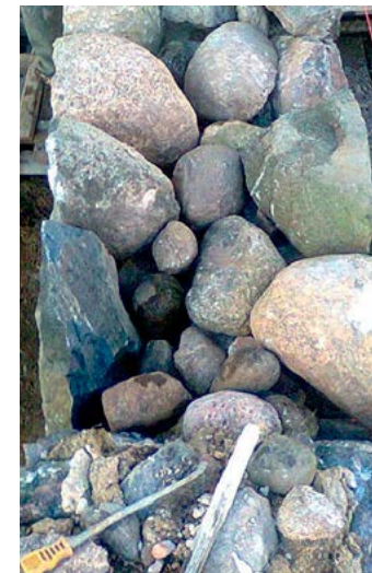
Müüri reakivide paigaldus ja sisu täitmine 90 cm ja 60 cm paksuse müüri puhul. Fotod: A. Peebo
