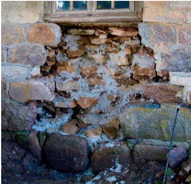
Kindlustatud aluskiht ja nakkekiht. Foto: A. Peebo
