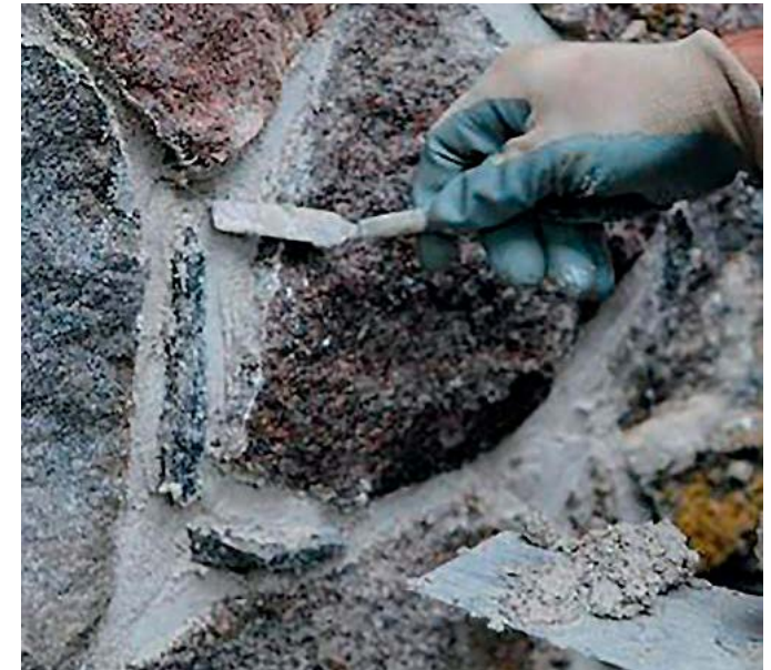
Vuukide puhastamine, niisutamine ja vuukimistööd. Fotod: A. Peebo
