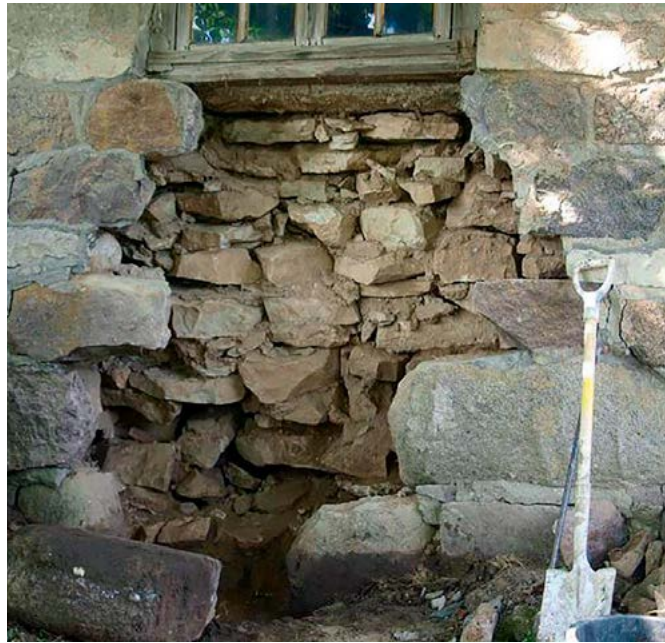
Puhastatud müüriosa. Foto: A. Peebo
