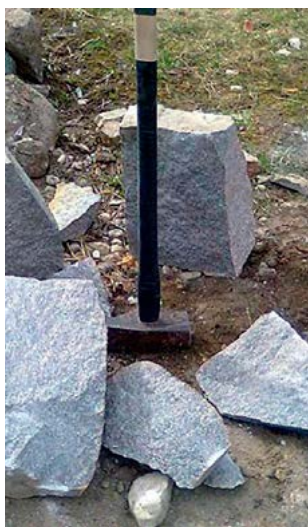
Kivide lõhkumine suurhaamriga ja nurgakivide lõhkumine. Fotod: A. Peebo
