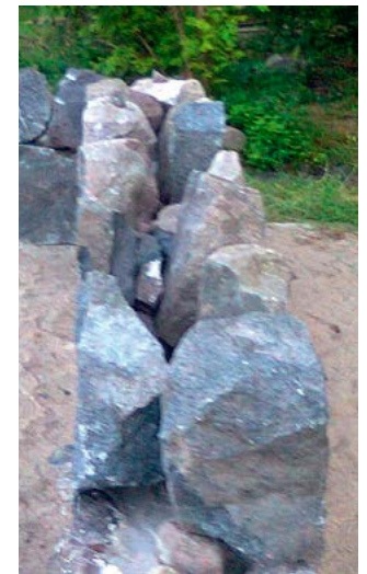
Müüri reakivide paigaldus ja sisu täitmine 90 cm ja 60 cm paksuse müüri puhul. Fotod: A. Peebo
