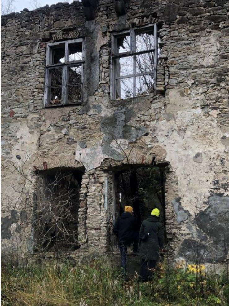
Töögrupp Kiltsi mõisa peahoone juures Läänemaal, sügis 2025
