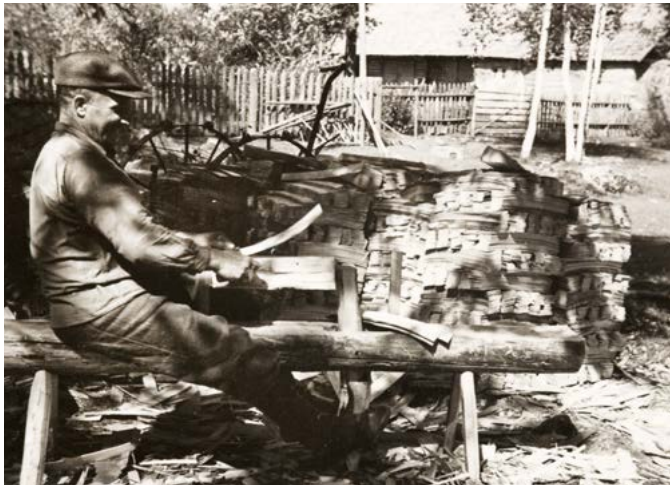
Katuse pilpa tõmbamine pilpatööpingil – Jakob Metsoja, 1947. aastal Avinurme vald, Tõnisma küla, Metsapoole talu. Foto: ERM Fk 1089:18
