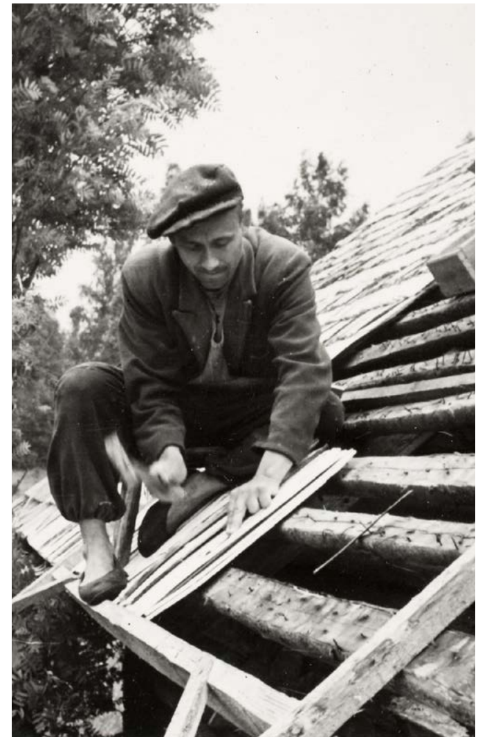
E. Koks laastu roovidele naelutamas. Saarde kihelkond, Tihemetsa vald, Metsa-Kurmi talu. Foto: ERM Fk 1298:285.
