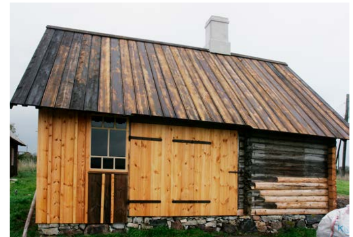
Puulaiu võrgukuur. Eeltõrvatud lauad vajavad uut katvat tõrvakihti. Foto: D. Lukas
