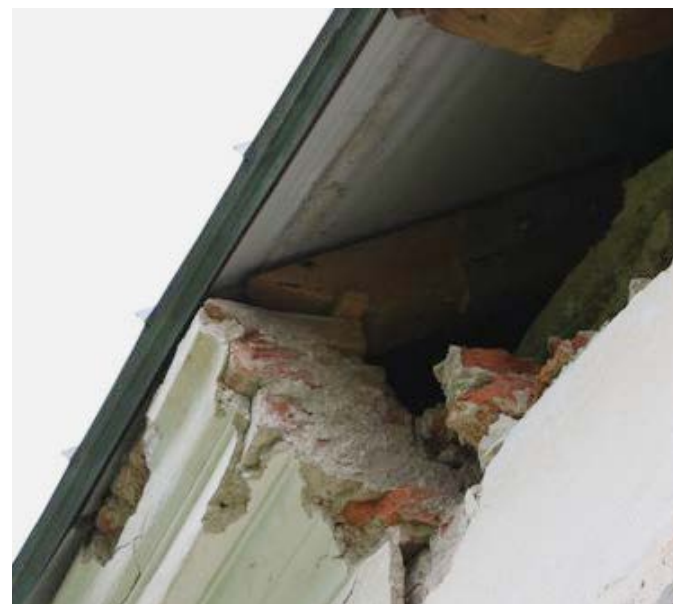
Karniis on alla kukkunud, kuna räästatõstja ja karniisi vahele olid pandud toeklotsid. Foto: J. Vali
