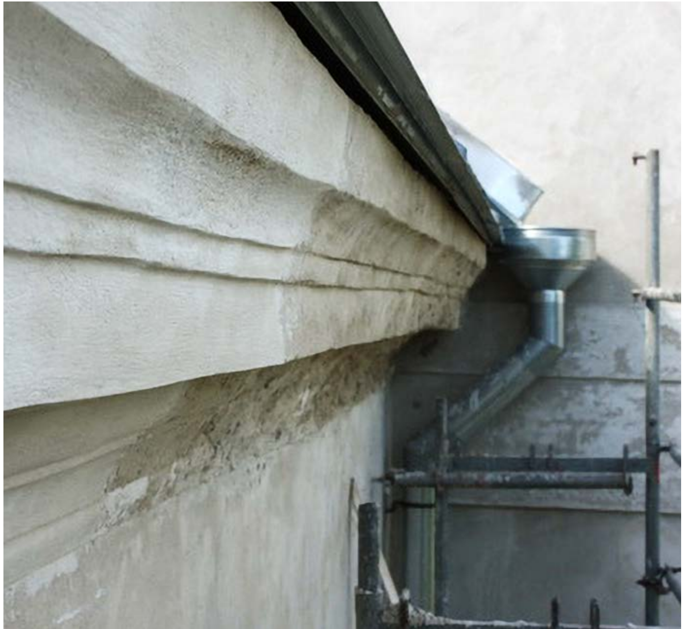
Jälgima peab ka karniiside sirgjoonelisust. Fotol oleva karniisi profiil ei ole korrektne. Foto: J. Vali
