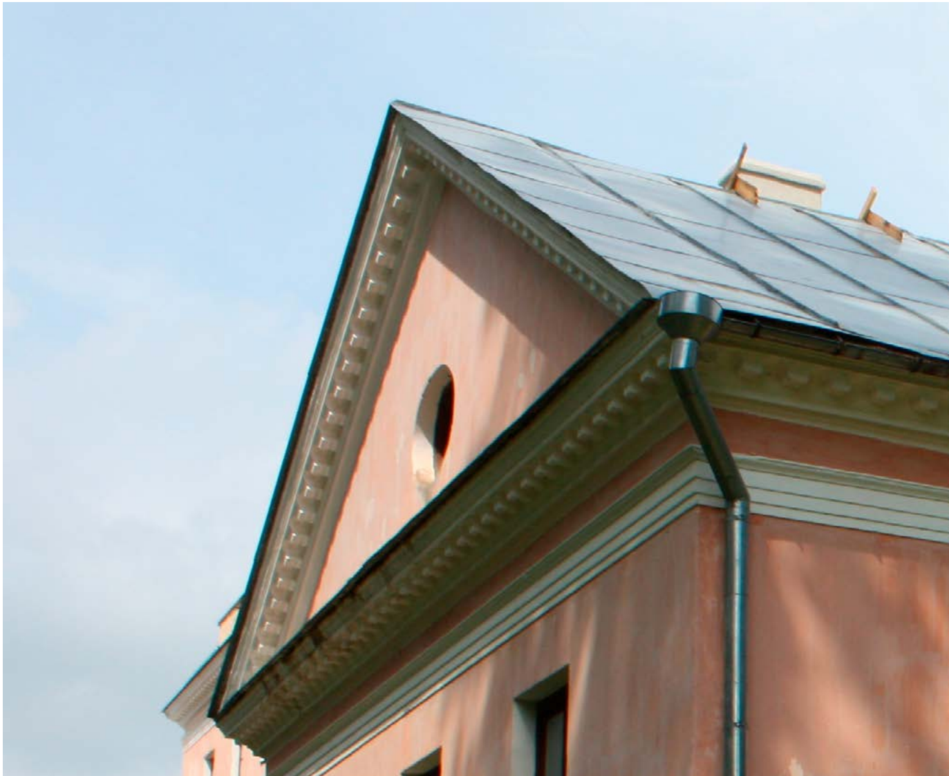
Otsaviilu karniisi lõpetav plekiserv peab olema terava äärega, ilma allapöördeta. Foto: J. Vali
