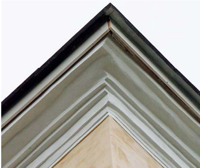
Oluline on järgida profiilide kokkujooksu. Kahe külje karniisi profiilid ei jookse kokku. Foto: J. Vali
