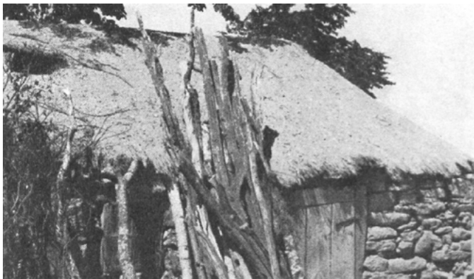
Õlgede ja saviseguga laetud katus Saaremaal Upa külas. Foto: G. Ränk „Saaremaa taluehitised. Etnograafiline uurimus I” (Tartu, 1939, lk 85).
