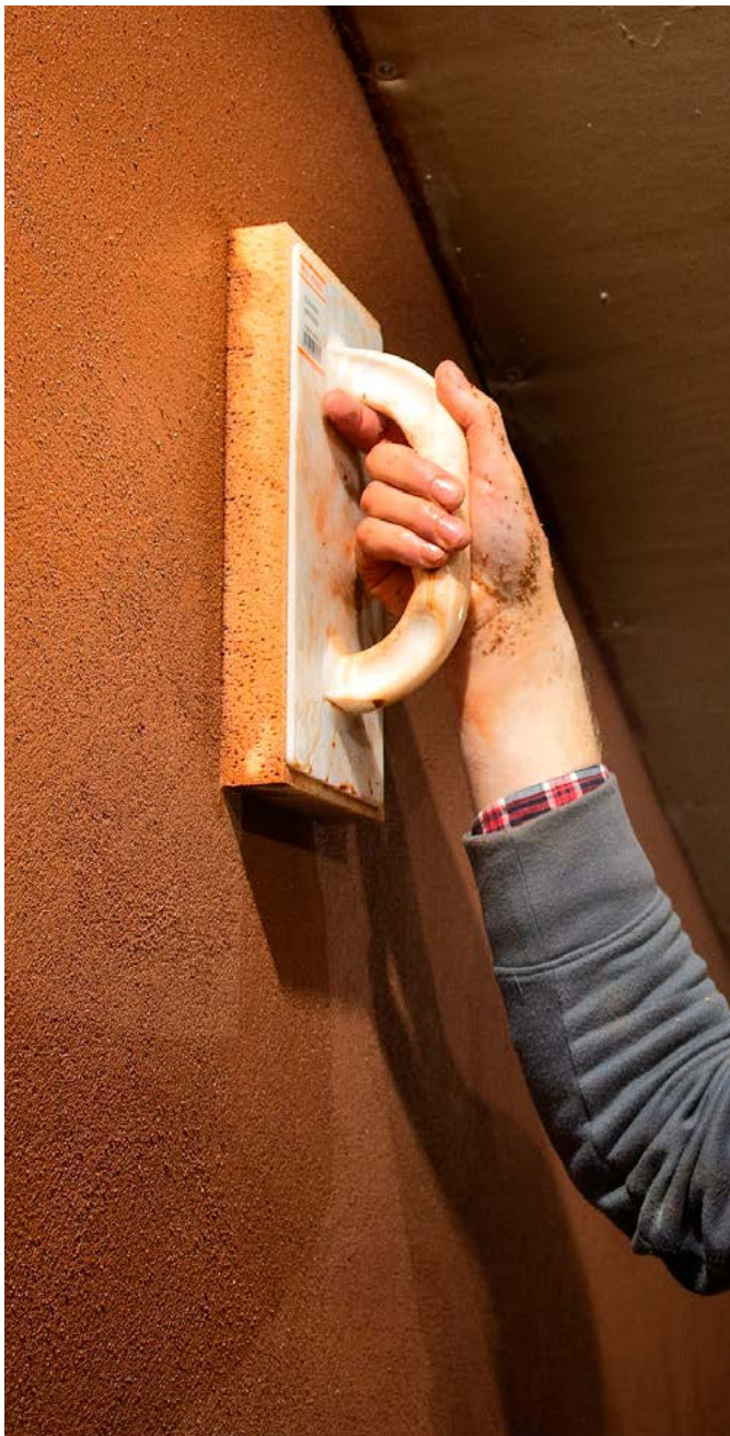
Viimase krohvikihhi niisutamine ja silumine svammhõõrutiga. Foto: Saviukumaja OÜ
