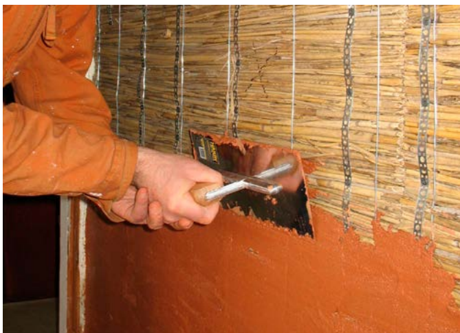
Liibiga esimese krohvikihhi seinale kandmine. Foto: M. Loit
