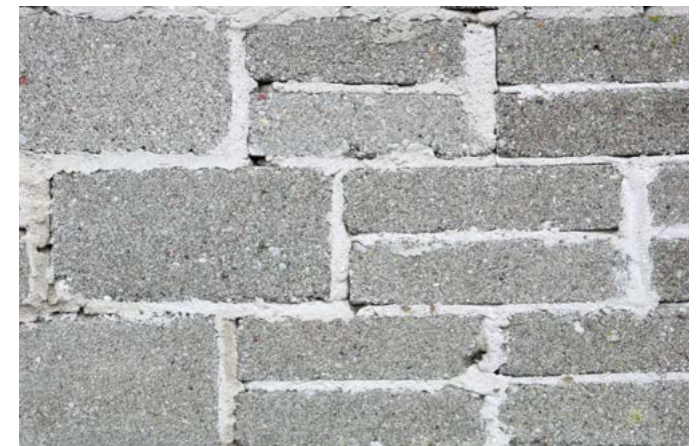
Nopsa seina nurk. Nopsa seinu ehitati sageli just betoontellistest. Foto: M. Mändel
