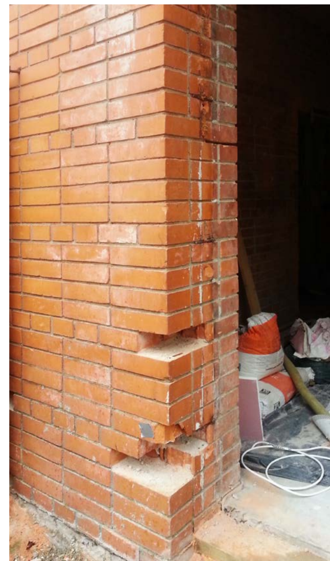
Tellismüüri parandamisel tuleb esmalt katkised tellised välja piigata. Foto: M. Mändel
