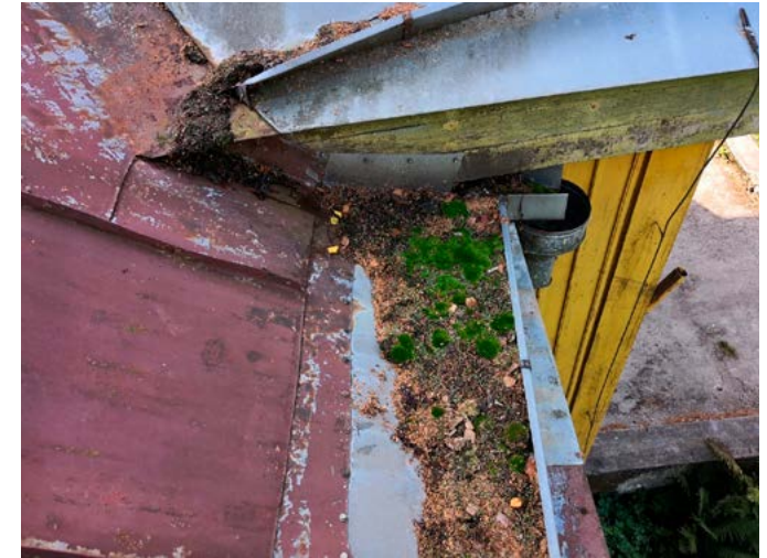
Puhastamata jäetud katusepealne renn takistab vee äravoolu katuselt. Foto: K. Kondio
