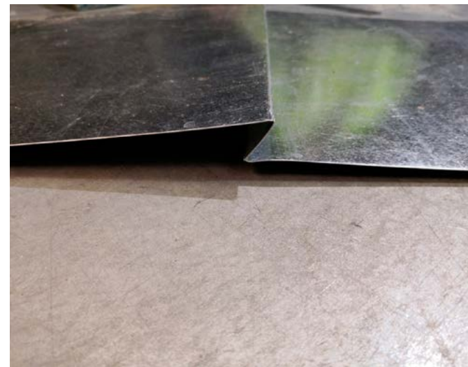
Valevaltsi lõige enne valtsi kokkulöömist. Plekk on täiesti terve. Foto: K. Kondio
