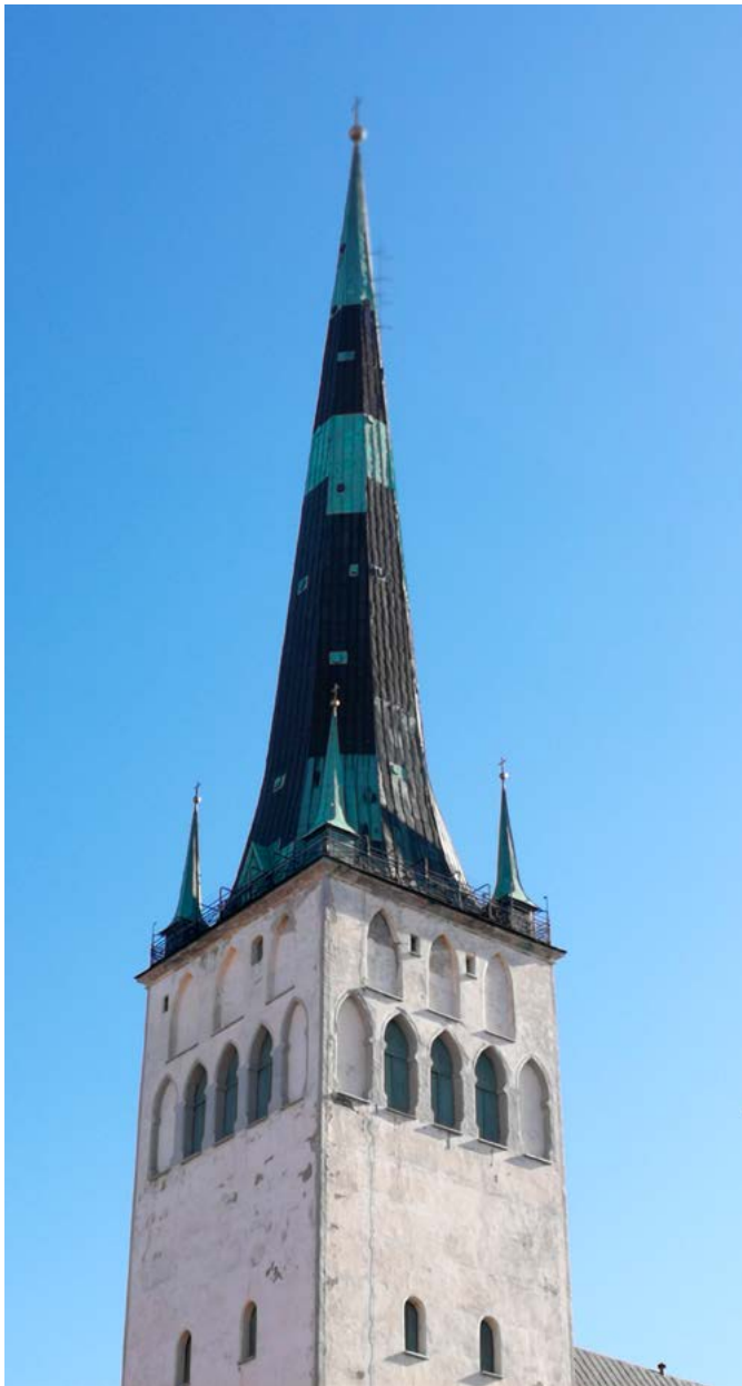
Tallinna Oleviste kiriku vaskplekiga kaetud tornikiiver 2019. aastal. Näha on nii vanem roheliseks patineerunud kui ka uuem pruunikas plekk. Foto: T. Reidla
