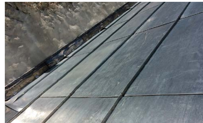
Valjala Martini kiriku apsiiditorni täistsinkplekist valtskatus 2015. aastal. Müüri ääres on pliiplekist põll. Foto: K. Kondio
