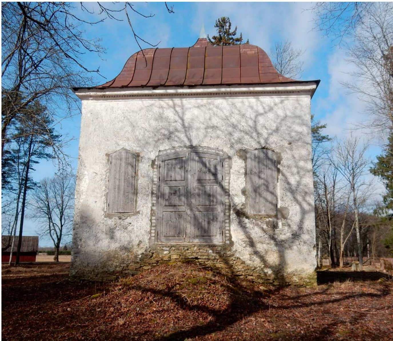
Purdi mõisa kabeli (Järvamaa) raudplekist katus 19. sajandist. Foto: S. Konsa
