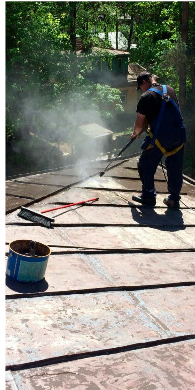
Katuse puhastamine enne värvimist. Foto: K. Kondio
