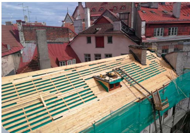
Plekialuse roovitise paigaldamine Tallinna vanalinnas. Foto: T. Reidla
