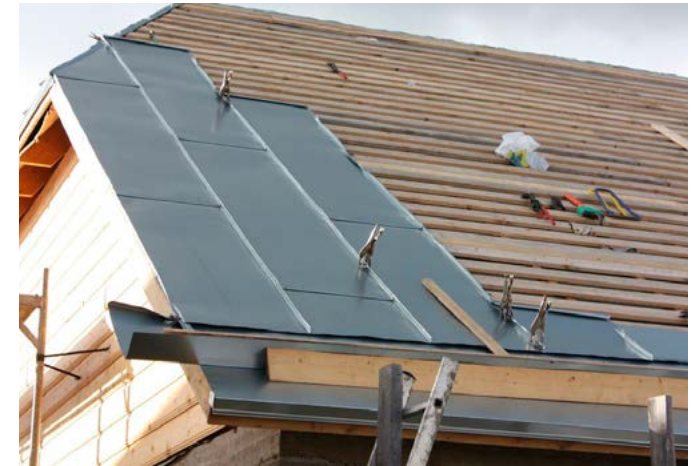
Plekk-katuse paigaldamine Lihulas. Foto: J. Vali
