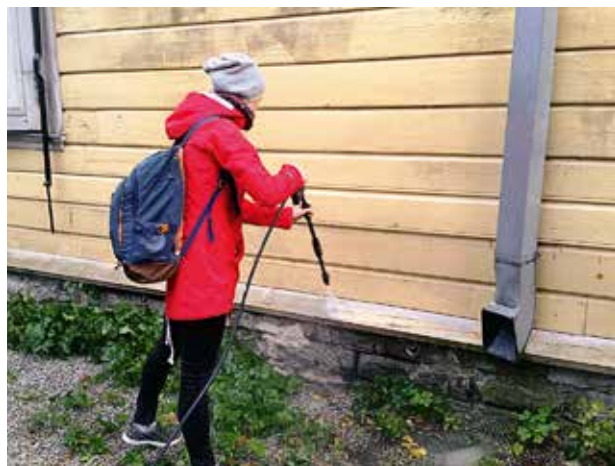
3. Hoone põhjaküljel kuivab aeglaselt. Seetõttu kipub niiskele seinale kogunema tolm ja seejärel võib seal hakata kasvama vetikas (seina alaossa tekib roheline kirme). Sellised määrduvad pinnad tasub puhtaks pesta. Puhastatud värvipind kuivab kiiremini ega kogu nii kergesti uut mustust. Foto Säästva Renoveerimise Infokeskus
