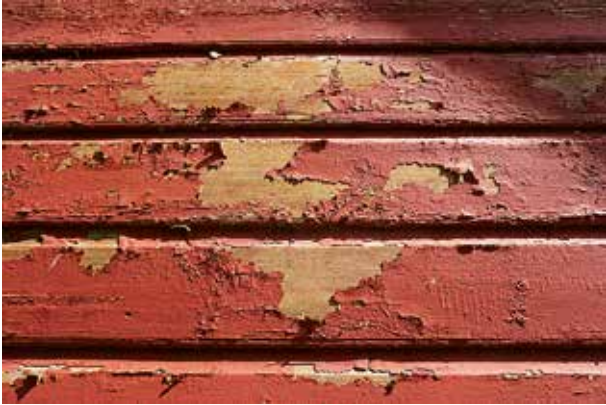
1.–2. Kooruv värv viitab kehvale värvitüübile ja kohese hoolduse vajadusele. Fotod Üllar Alev
