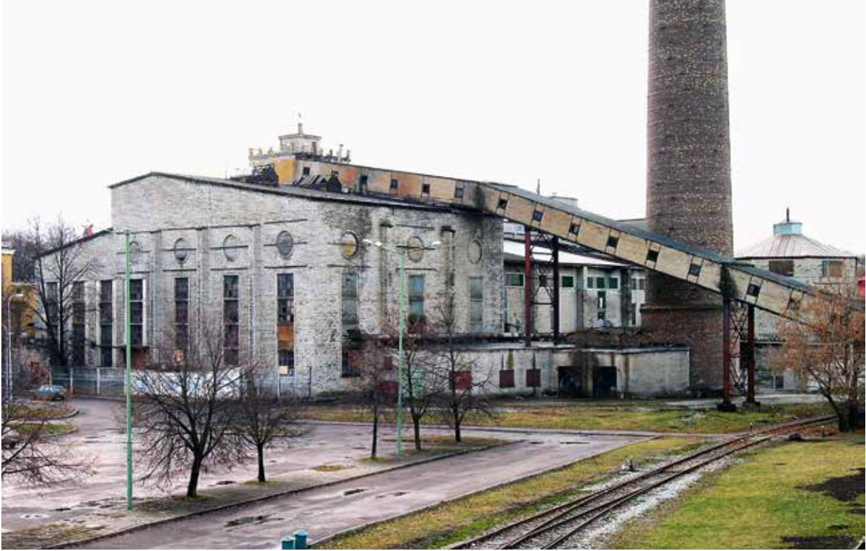
7. Tallinna elektrijaama suur estakaad, mis on praeguseks lammutatud. Foto Monika Eensalu-Pihel
